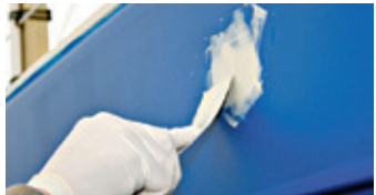
Punktspackla med kittkniv eller smalspackel
