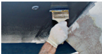
Eftersläta Hempel's High Protect II i andra riktningen med pensel
